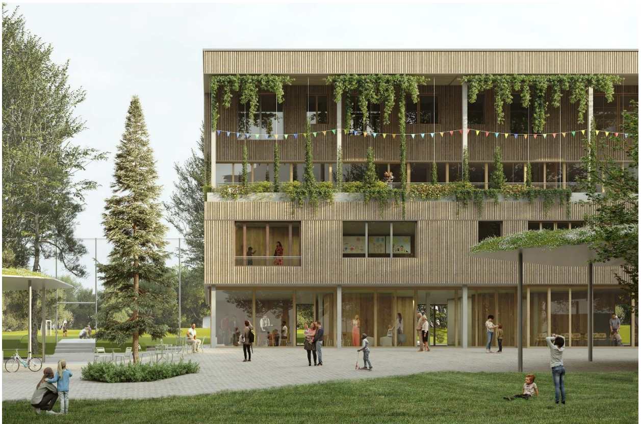
Bâtiment Espace familles - Vue de l'entrée depuis l'esplanade coté Salève
