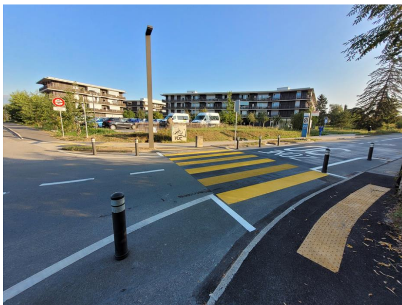
Figure 2 : Photo du passage pour piéton réalisé en 2024
