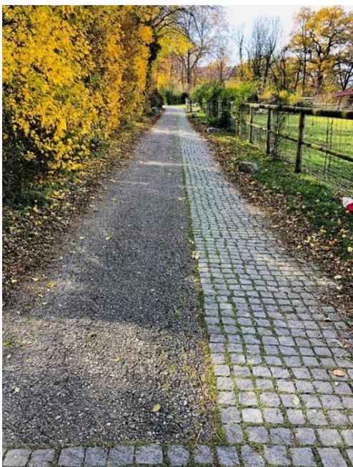
Techniquement parlant, la structure actuelle du chemin existant allant de la route du Bois-des-Frères jusqu'en limite de la parcelle 830 permet, même si elle n'est pas dimensionnée pour un trafic poids lourds, de supporter le passage très occasionnel des véhicules du SIS sans la détériorer outre mesure. Une reprise partielle de la couche de roulement est tout de même à prévoir.
