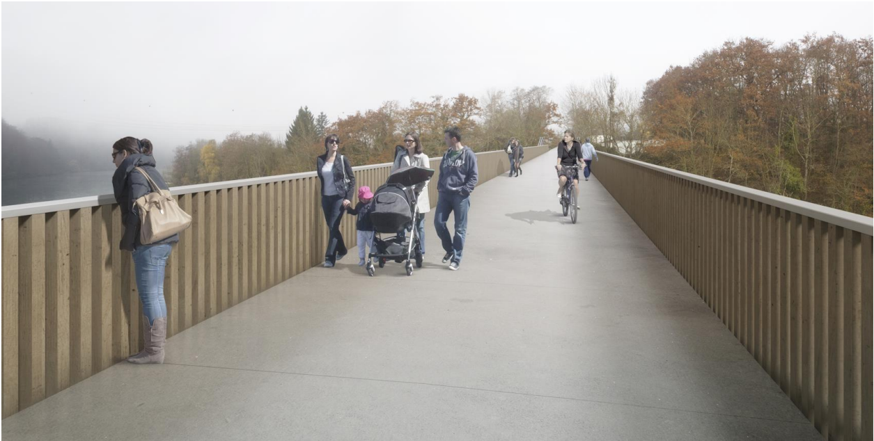
Figure 3 : largeur augmentée et modification des garde-corps par suite des problèmes de dimensionnement rencontrés
