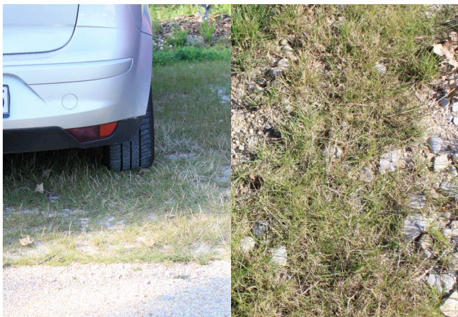
Mélange terre-pierre sur stationnement et sur route
