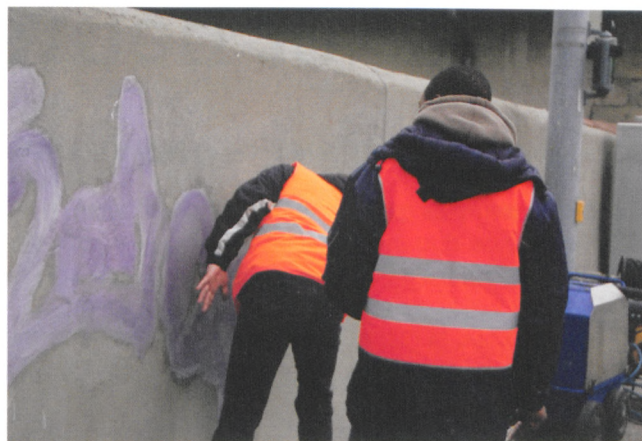
Avant le jet, il convient d'appliquer une couche d'un produit bio-dégradable
