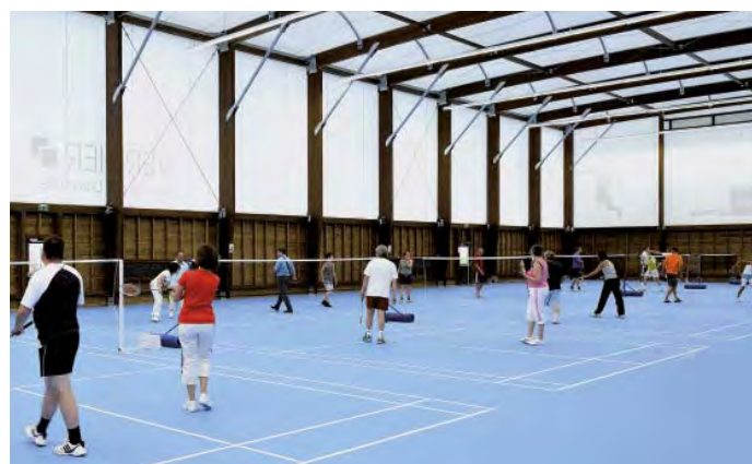
Située dans l'enceinte du tennis de Vernier, la nouvelle halle de badminton offre six terrains.
