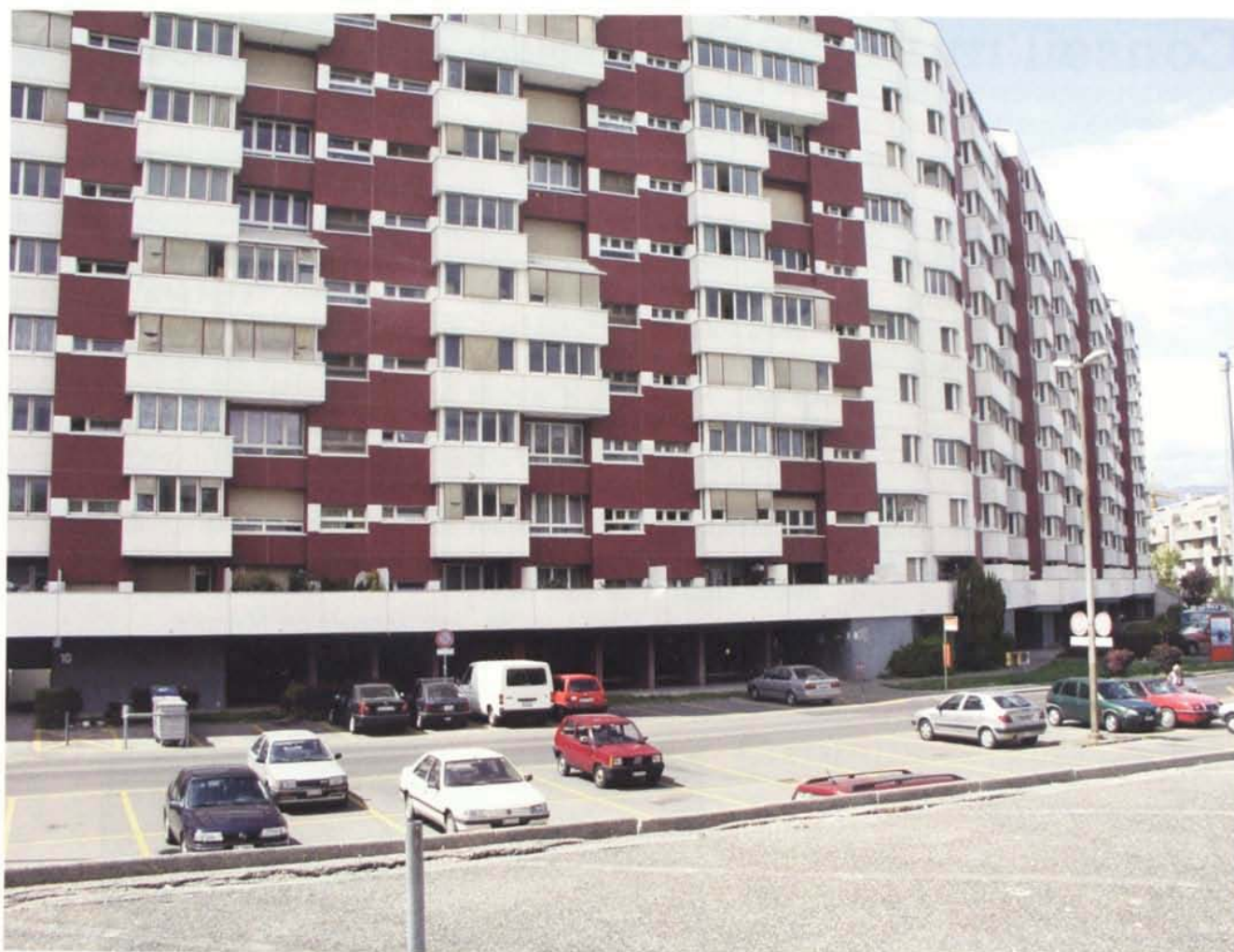
Les Libellules abritent 504 logements HBM
