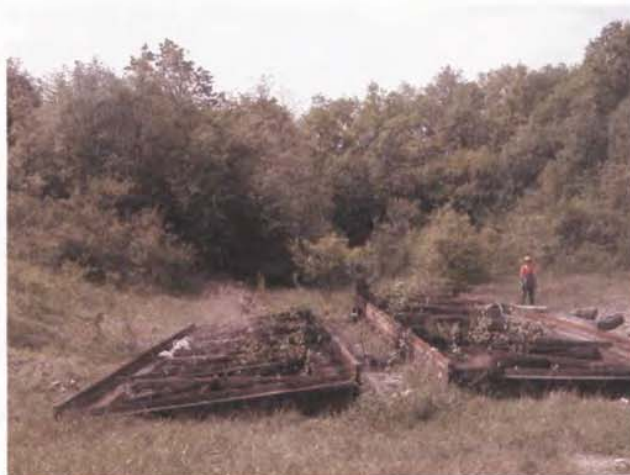
le pont va pouvoir être découpé
