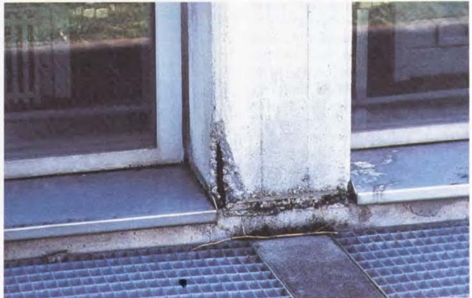
Exemple de carbonatation sur un bâtiment communal
