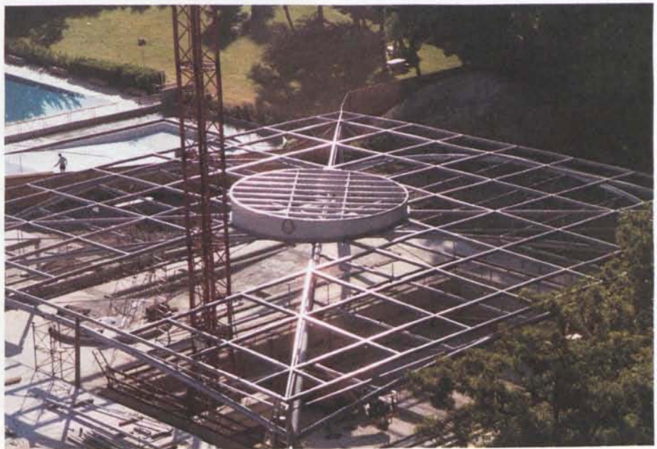
Juin 96 : Lanterneau sur structure métal de la halle posé
