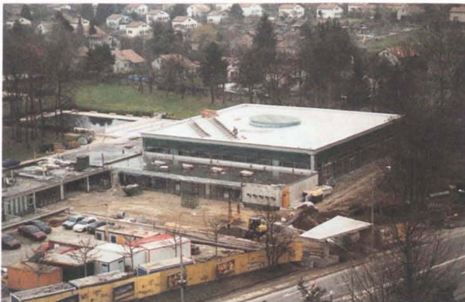
Janvier 97 : Vue générale depuis les immeubles du Lignon, pose des capteurs solaire en cours
