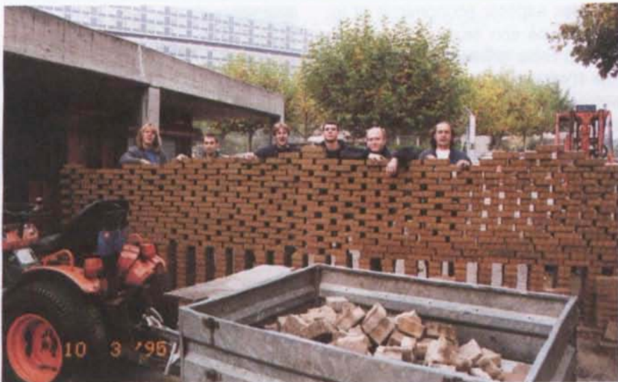
Octobre 95 : Oeuvre architecturale réalisée par l'équipe du Service des sports lors de la dépose des pavés de l'accès
