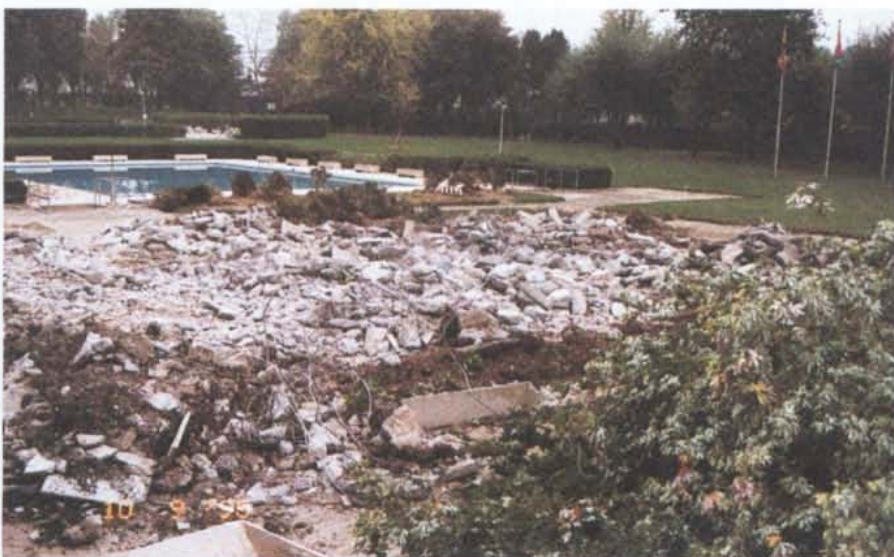
Octobre 95 : Démolition de la pataugeoire existante
