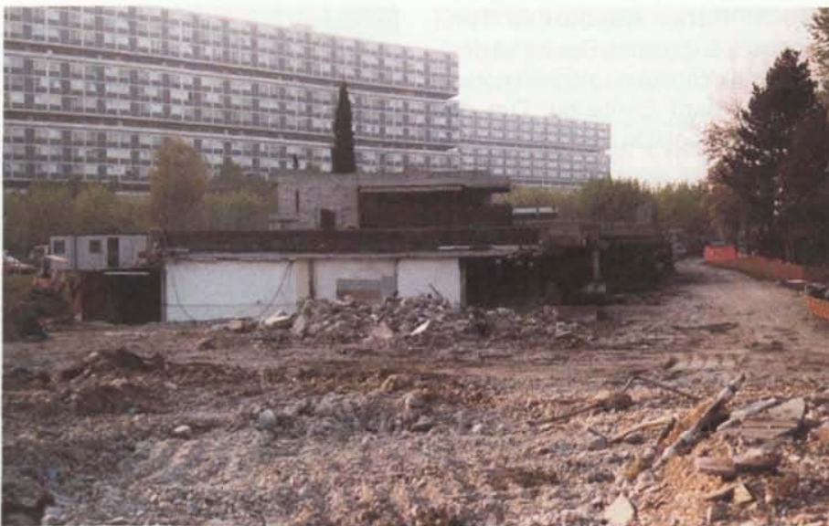
Novembre 95 : Partie du bâtiment existant démolie
