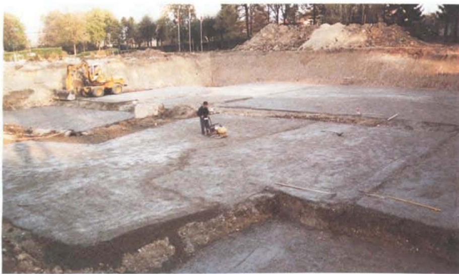
Novembre 95 : Terrassement terminé, pose du béton de propreté zone bassin
