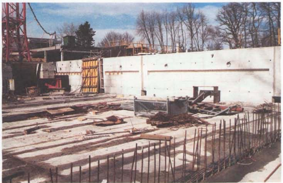
Février 96 : Construction des murs du bassin
