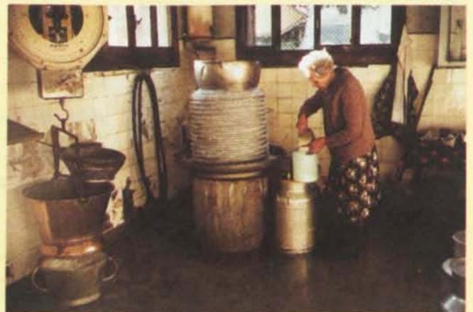
3 - La laitière, le filtre, la balance et le prérefroidisseur
