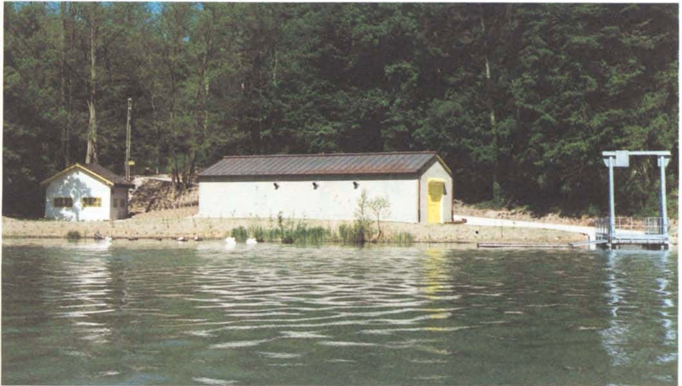
Station de pompage des pétroliers de Vernier
