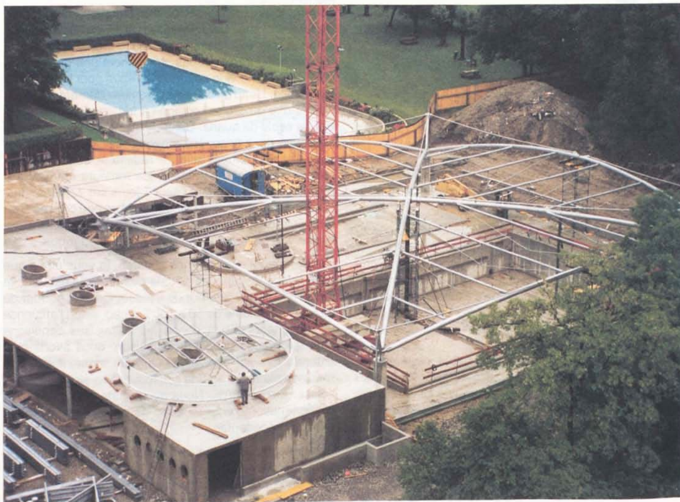
Montage de la structure métallique
