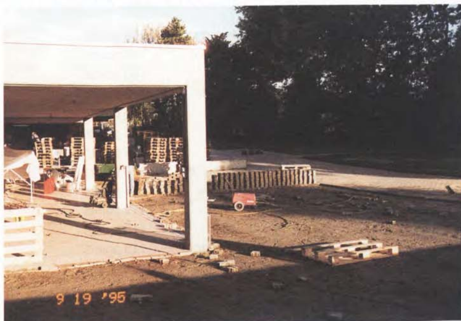
Démontage de la terrasse par le Service des sports
