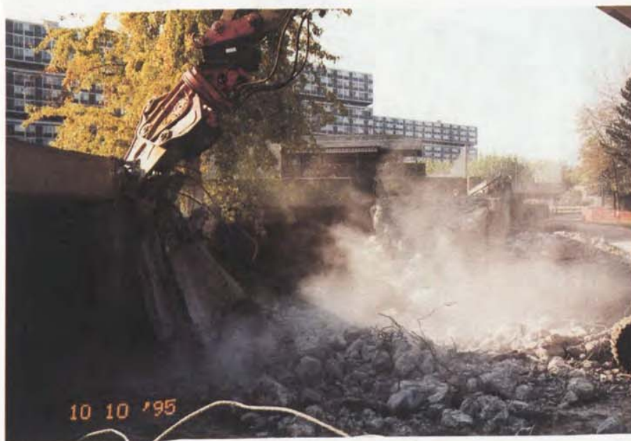
Démolition de la structure du restaurant
