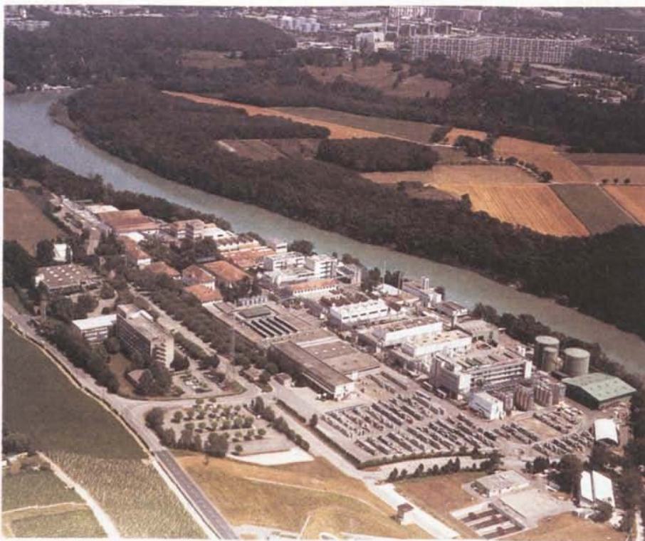
Vue aérienne de l'entreprise GIVAUDAN-ROURE
