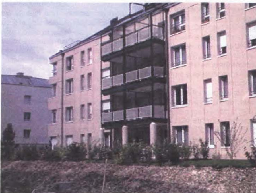
Construction (FMCV) au chemin des Myosotis
