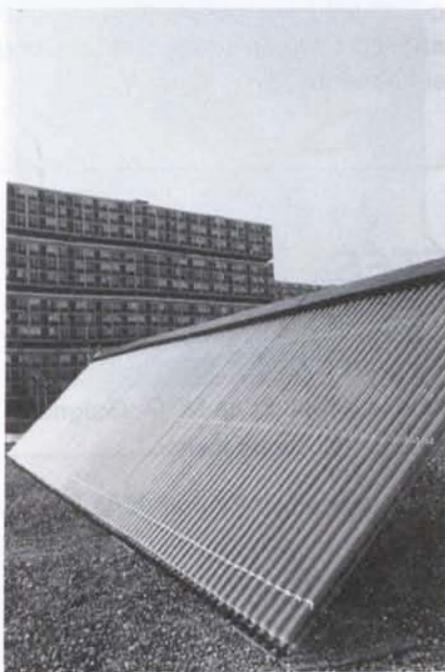
L'énergie solaire captée à l'intérieur des tubes est acheminée vers les chaufferies par un fluide caloporteur et contribue au préchauffage de l'eau, jusqu'à 95 degrés, ce qui permet d'économiser les énergies habituellement utilisées pour la production d'eau chaude.
