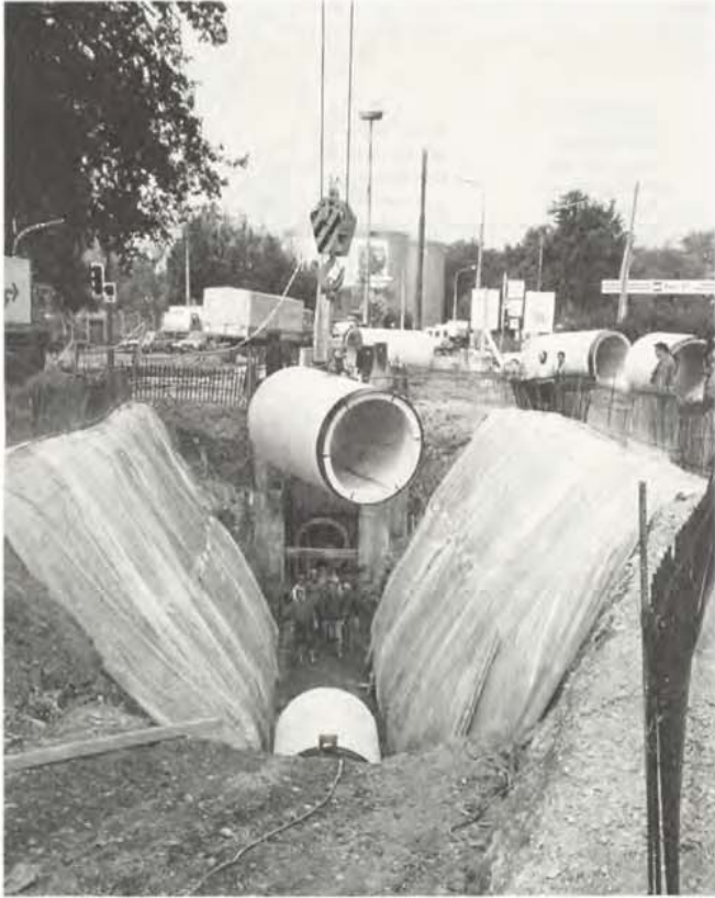
Pose du collecteur route de Vernier - Philibert-de-Sauvage
