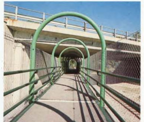
La passerelle sous la route du Bois-des-Frères fait partie de la liaison pédestre entre le secteur des « Libellules » et le Bois-des-Frères.
