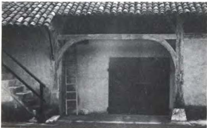
Photo 2 Sommier sur poteau ou ancienne couverte de porte de grange, à Peney. L'état est typiquement celui d'une ferme du XVII e . On remarquera en particulier les poteaux de chêne sur dais en «roche», les bras de force cintrés avec mordane, le rampant à faible inclinaison couvert de tuiles canal, dont on appréciera la souplesse. L'escalier de bois a malheureusement été bétonné, et la façade crépie au ciment fait catastrophique.
