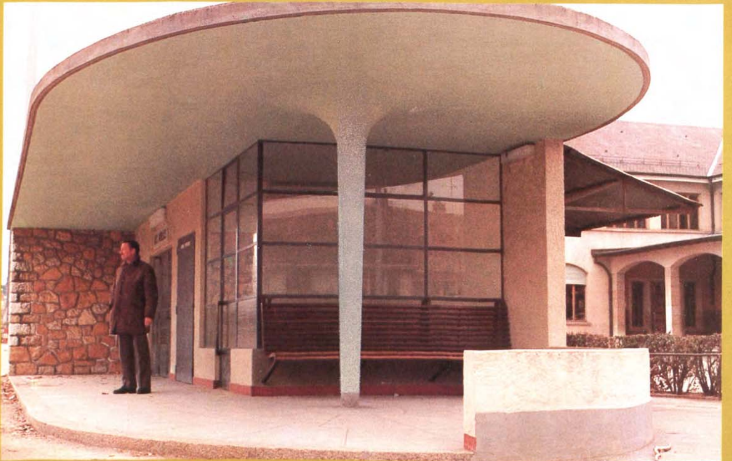
Station de Vernier réalisée en 1939
