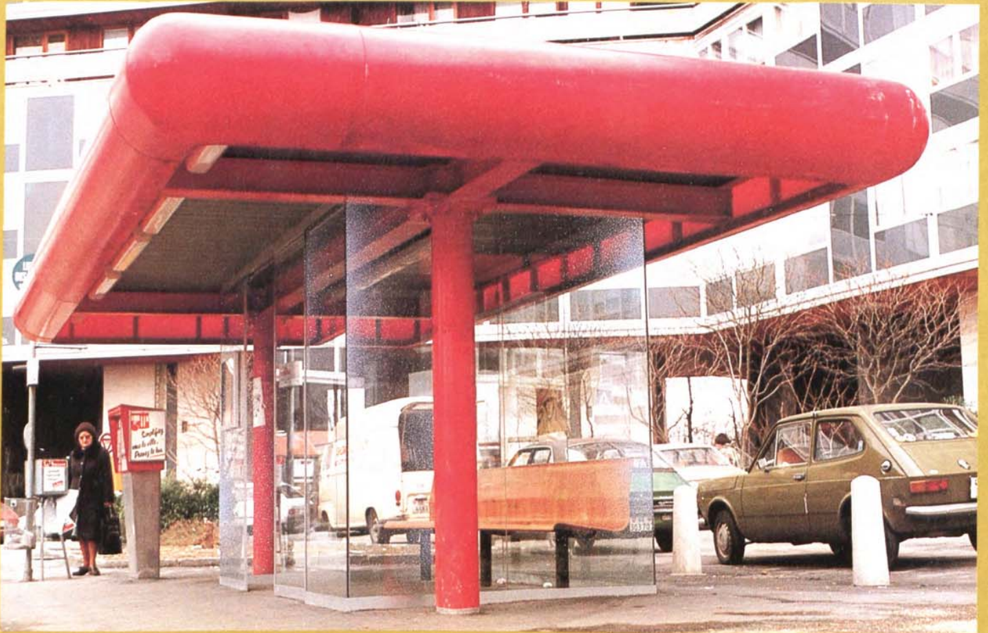
L'abri réalisé au Lignon en 1979
