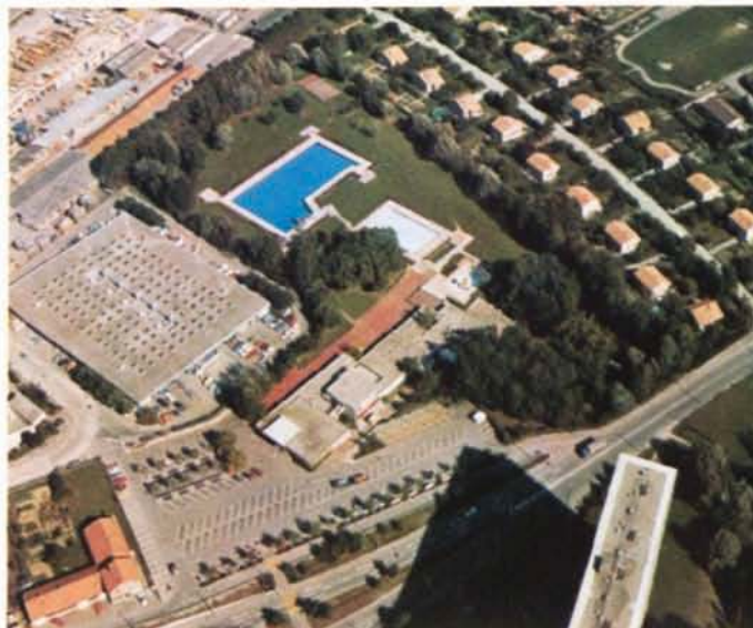
Photo d'ensemble de la piscine
