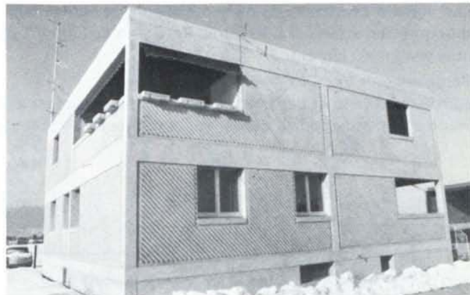
Centre de voirie, le bâtiment administratif
