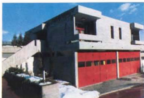
L'appartement du concierge de la piscine ainsi que les garages
