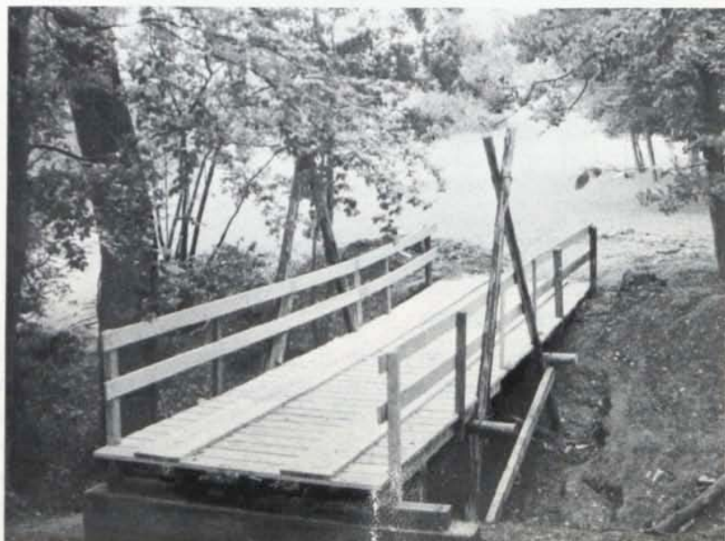
Passerelle construite au Lignon par la Protection civile
