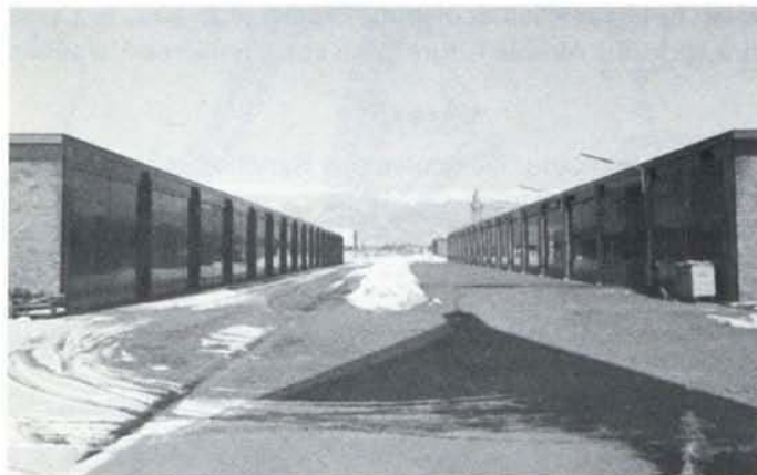
Centre de voirie, les hangars
