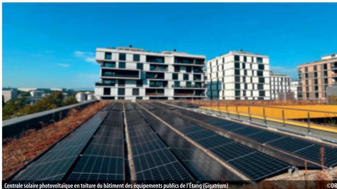
Centrale solaire photovoltaïque en toiture du bâtiment des équipements publics de l'Étang (Gigatrium)
