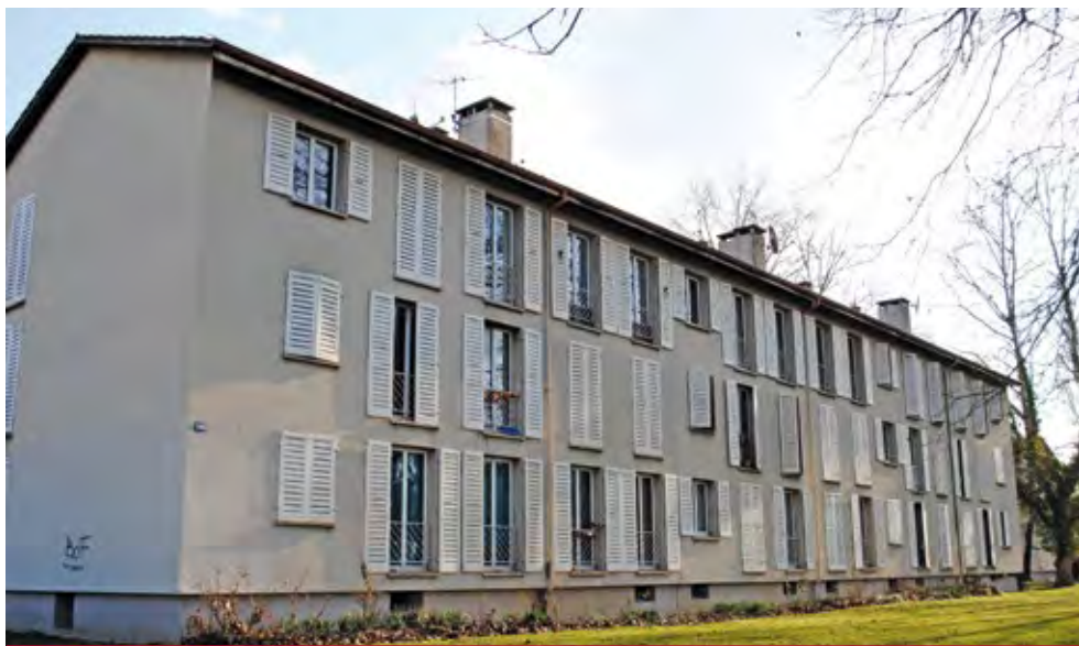
Un des immeubles de la route de Vernier faisant partie du périmètre du projet «une nouvelle lumière» à Châtelaine.
