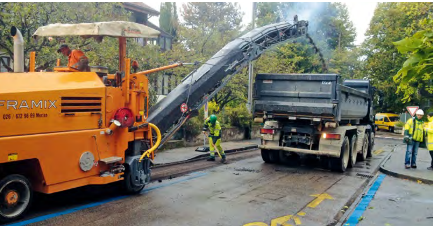
Travaux routiers au chemin des Anémones.
